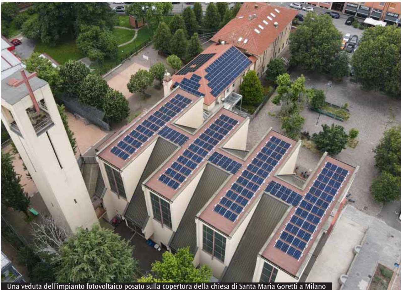
Una veduta dell'impianto fotovoltaico posato sulla copertura della chiesa di Santa Maria Goretti a Milano
