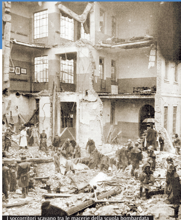
I soccorritori scavano tra le macerie della scuola bombardata
