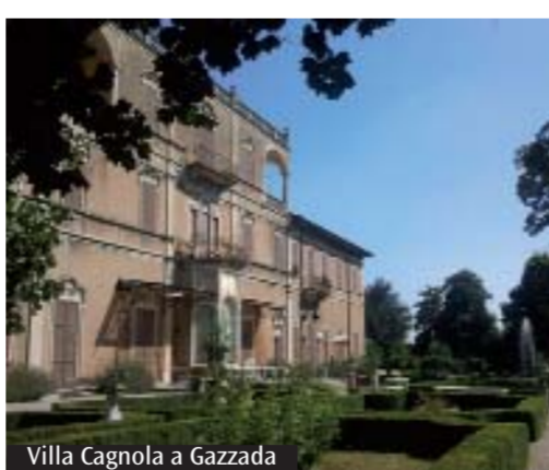
Villa Cagnola a Gazzada
