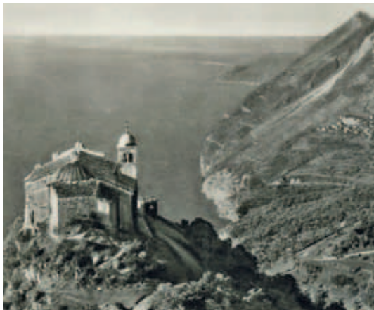
Il santuario prima della costruzione della Casa di esercizi.
