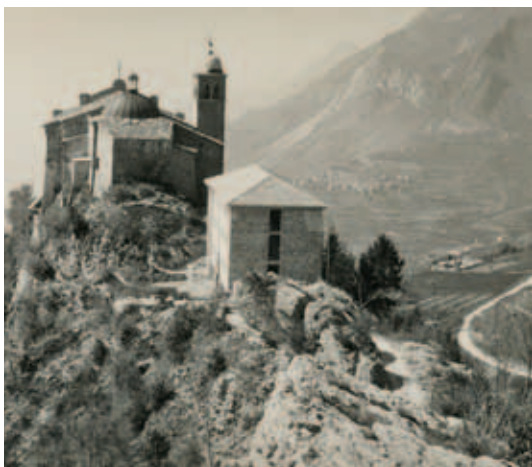
La Casa portata al tetto.
