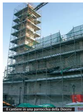
Il cantiere in una parrocchia della Diocesi
