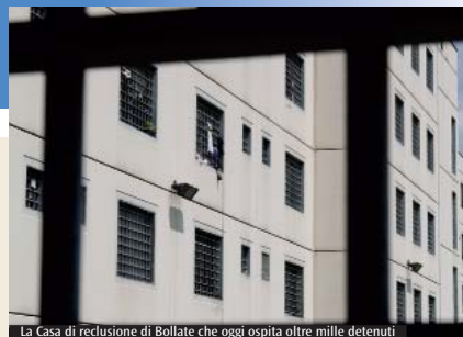
La Casa di reclusione di Bollate che oggi ospita oltre mille detenuti
