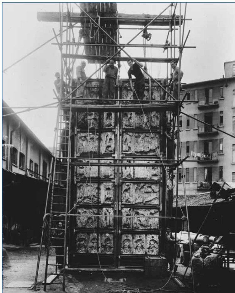
Milano, Cantiere della Veneranda Fabbrica del Duomo: operazioni di montaggio dei battenti della Porta Minerbi (1948)
