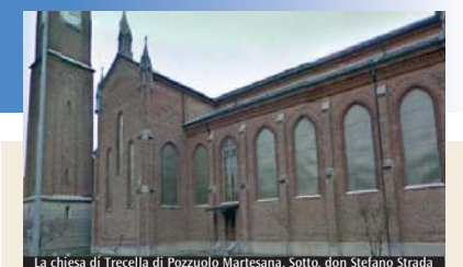
La chiesa di Treccella di Pozzuolo Martesana. Sotto, don Stefano Strada
