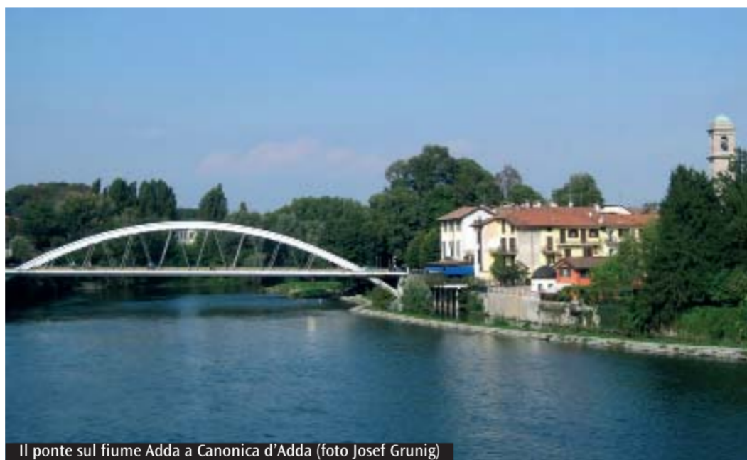
Il ponte sul fiume Adda a Canonica d'Adda (foto Josef Grunig)
