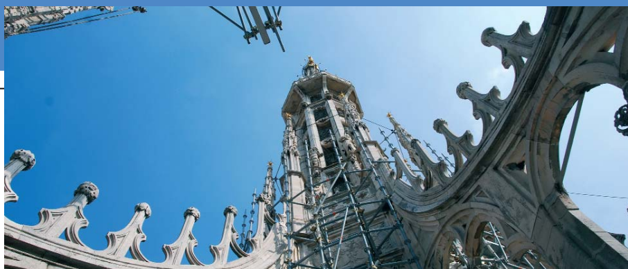
La Guglia maggiore con la Madonnina durante i lavori di restauro (foto L. Frigerio) Sotto, il Duomo di Milano
