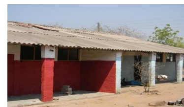
Chipanga-odi in corso di ristrutturazione
