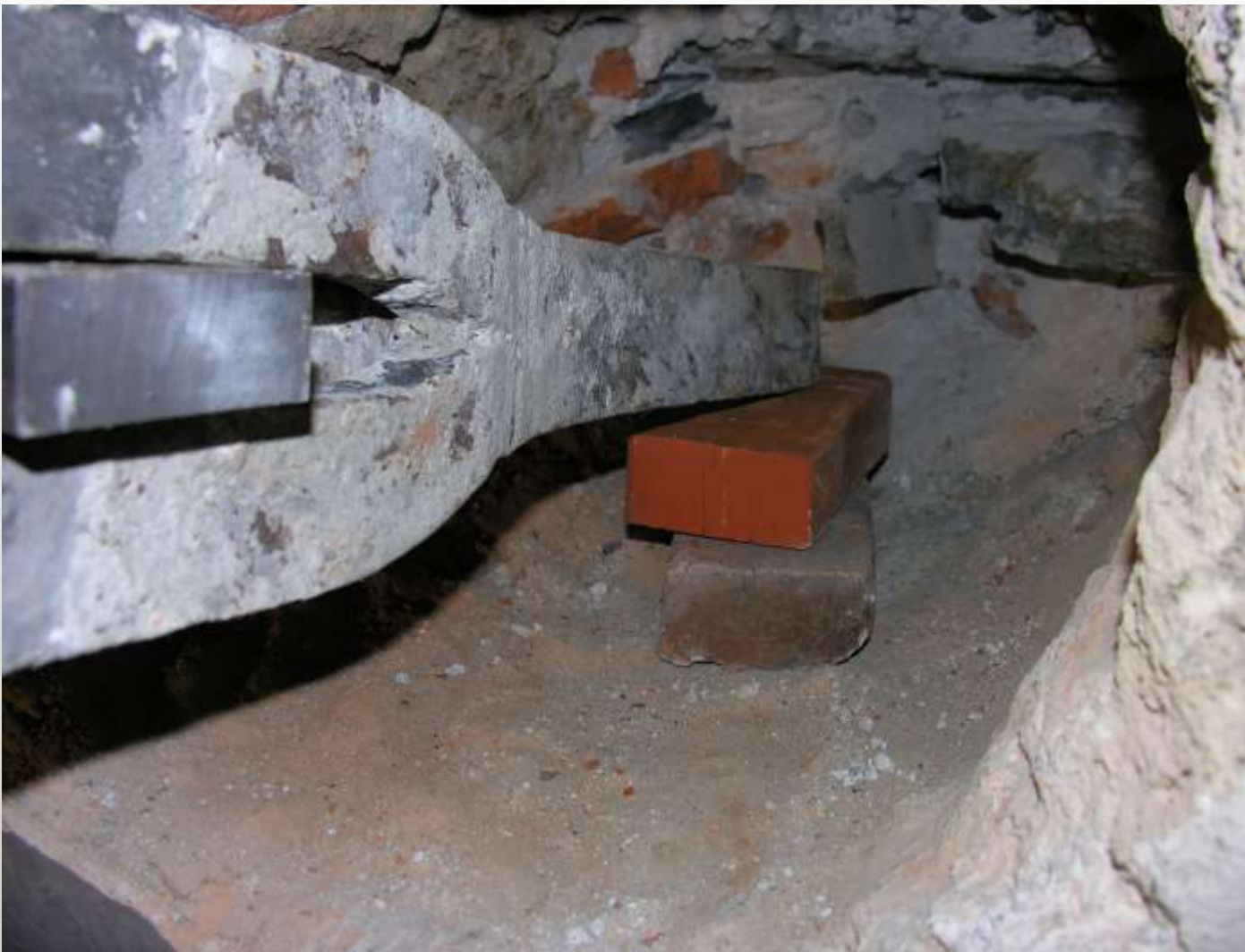
ROTTURA DI UN TIRANTE
