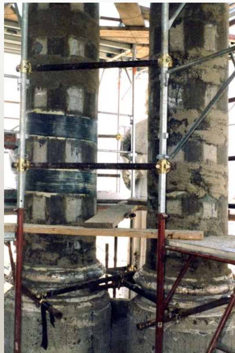
Dopo la rialcalinizzazione, fasciatura con fibre al carbonio
