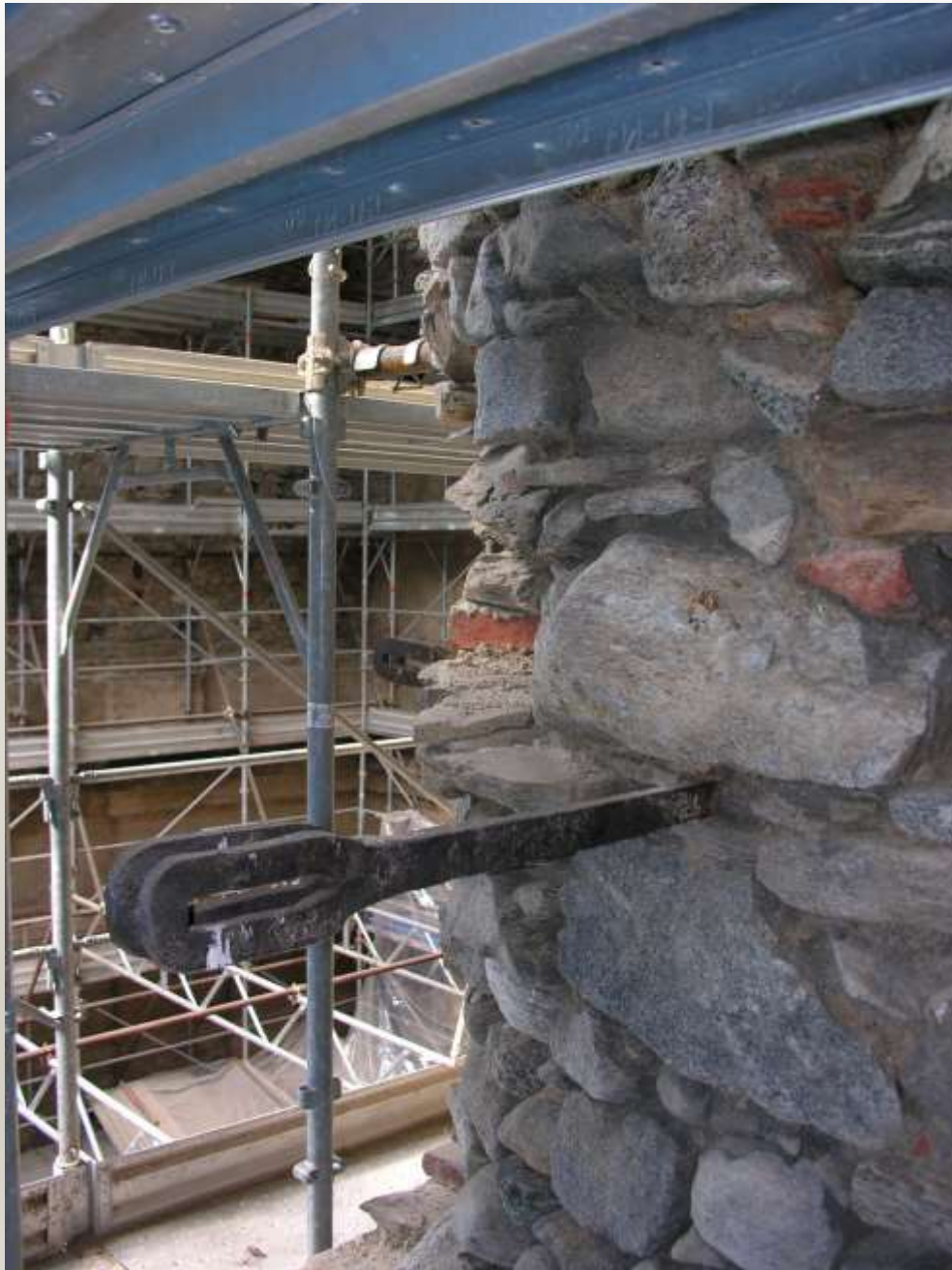
CAPOCHIAVE METALLICO CHE TIENE CONTO DELLO SPESSORE DELLA VOLTA E CON L'ASOLA PER L'INSERIMENTO DEL TIRANTE CENTRALE
