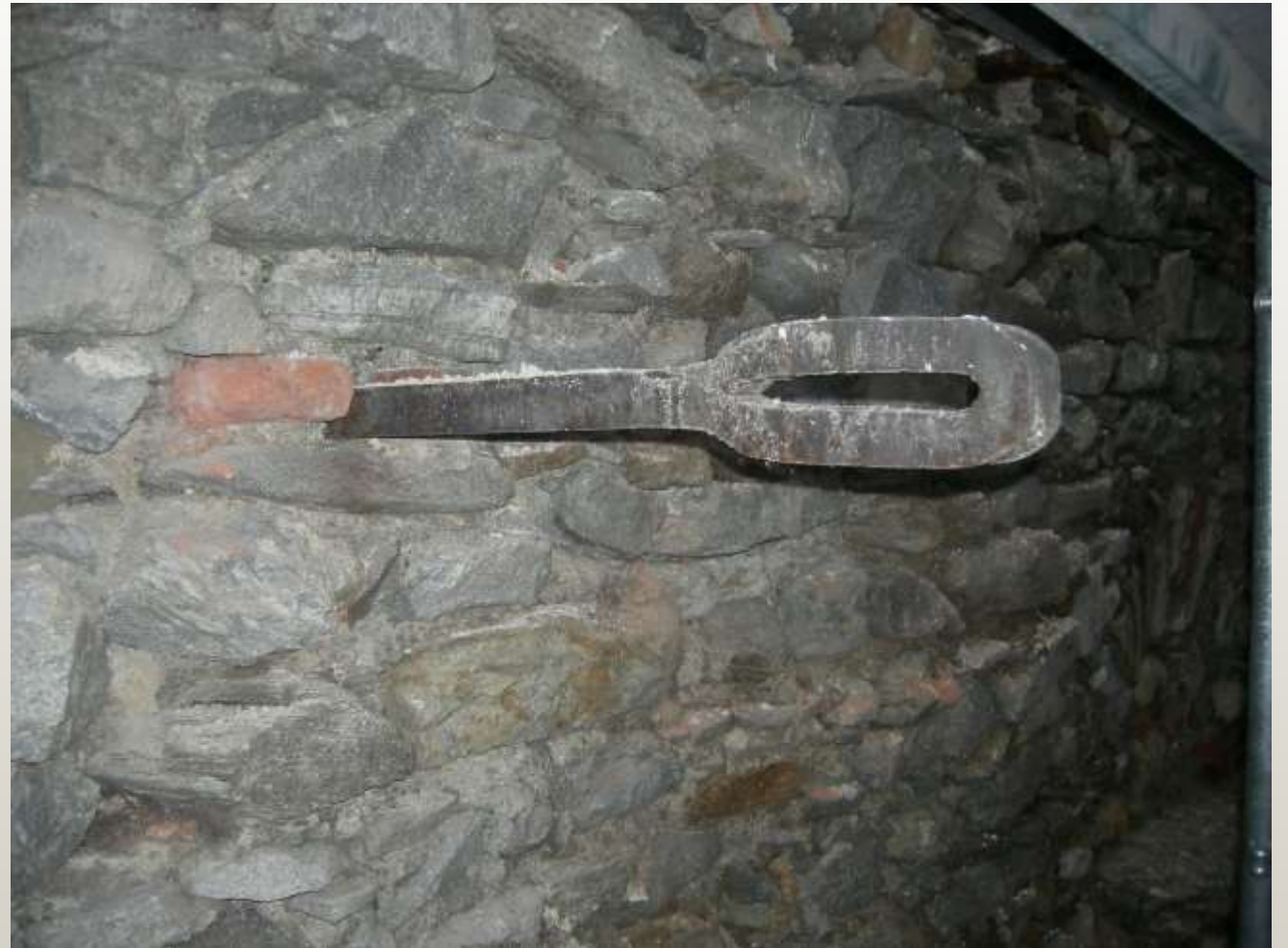
CAPOCHIAVE METALLICO CHE TIENE CONTO DELLO SPESSORE DELLA VOLTA E CON L'ASOLA PER L'INSERIMENTO DEL TIRANTE CENTRALE
