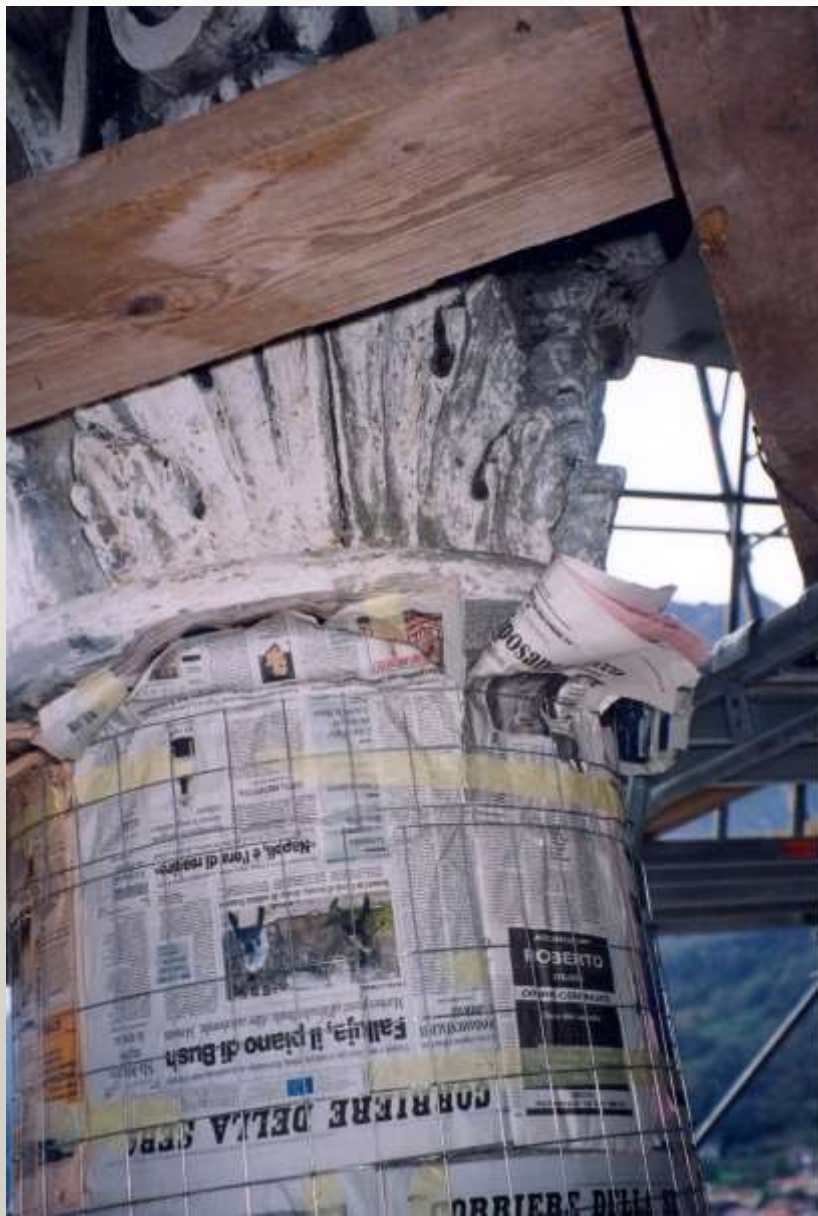
RIALCALINIZZAZIONE: REALIZZAZIONE pasta di cellulosa sostituita con fogli di giornale
