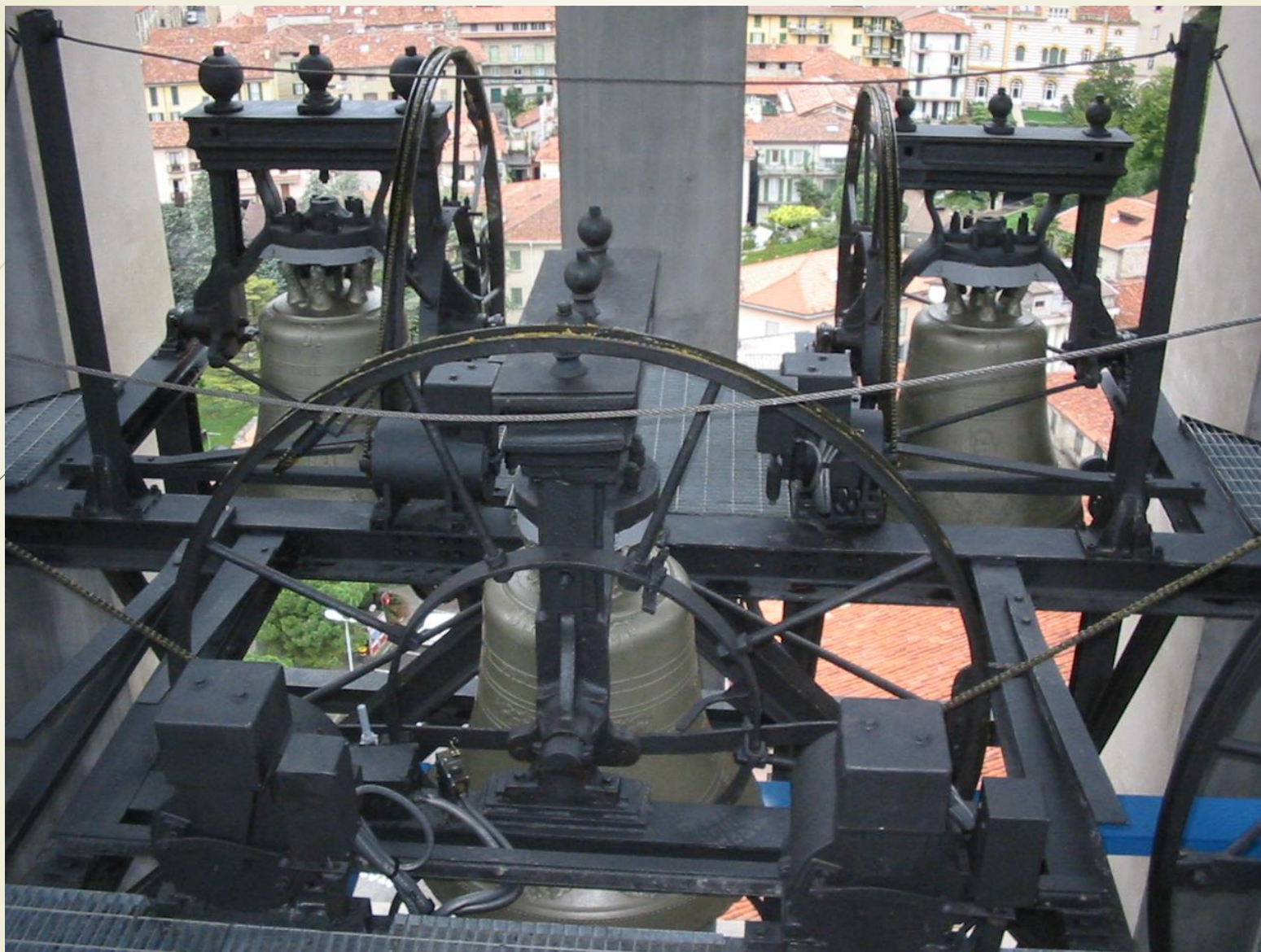
Campane su incastellatura di sostegno
