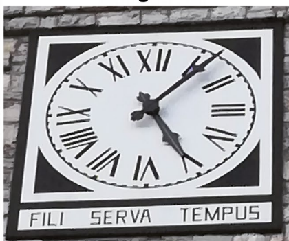
Binago (VA) Restauro orologi da torre - 2018
