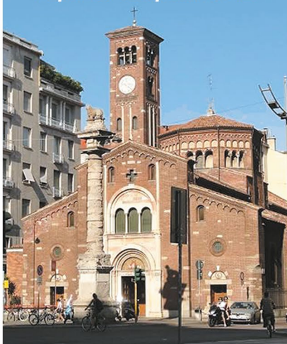
Basilica di San Babila - Milano Impianto campanario AEI
